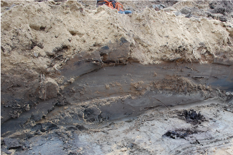
Afb 12. Overzichtsfoto van de vier palen in het natuurlijke zand. Hier is goed te zien dat de palen al aan de bovenzijde beschadigd waren. Op de voorgrond is het vulzand te zien.
